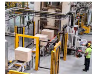
復旧稼働直後の工場パルプ設備
