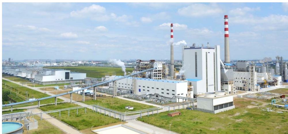
南通工場全景
