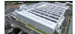
王子コンテナー栃木工場 太陽光発電設備
