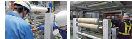
新設備の安全点検
