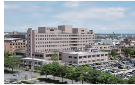
王子総合病院外観
