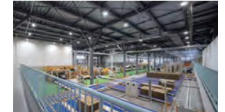
王子コンテナー板木工場
