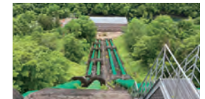
千歳第一水力発電所
