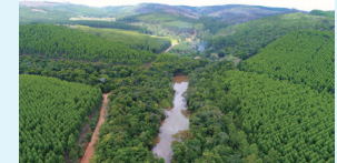
自社林内に設置した貯水池
